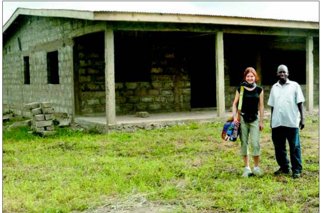
Der Rohbau des Waisenheims bei Ho in der Voltaregion steht. Simone Daniel aus Achern hat sich mit Mr. Danso über den Stand der Bauarbeiten informiert.
